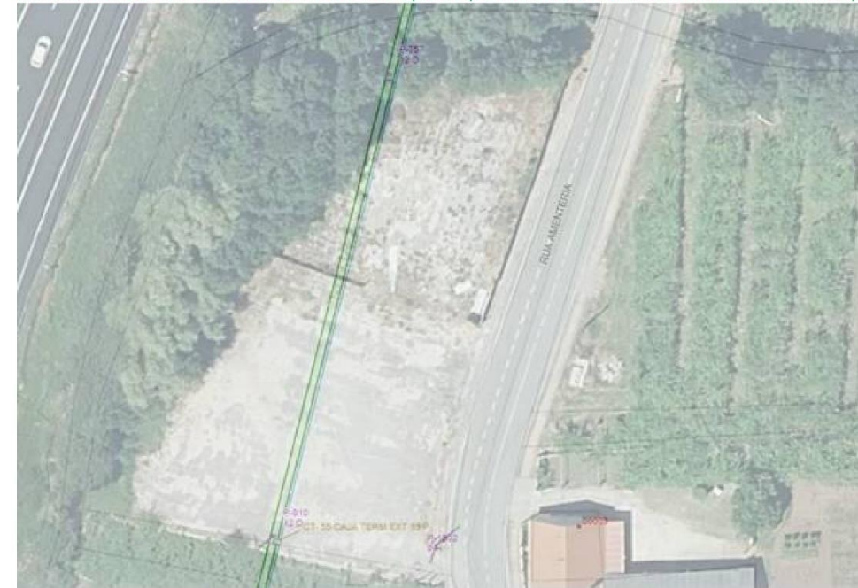
CALDAS: Hay conducción de Telefónica en el entorno de la nueva senda proyectada, pero se considera que no hay afectación pues no son necesarios movimientos de tierra importantes.
