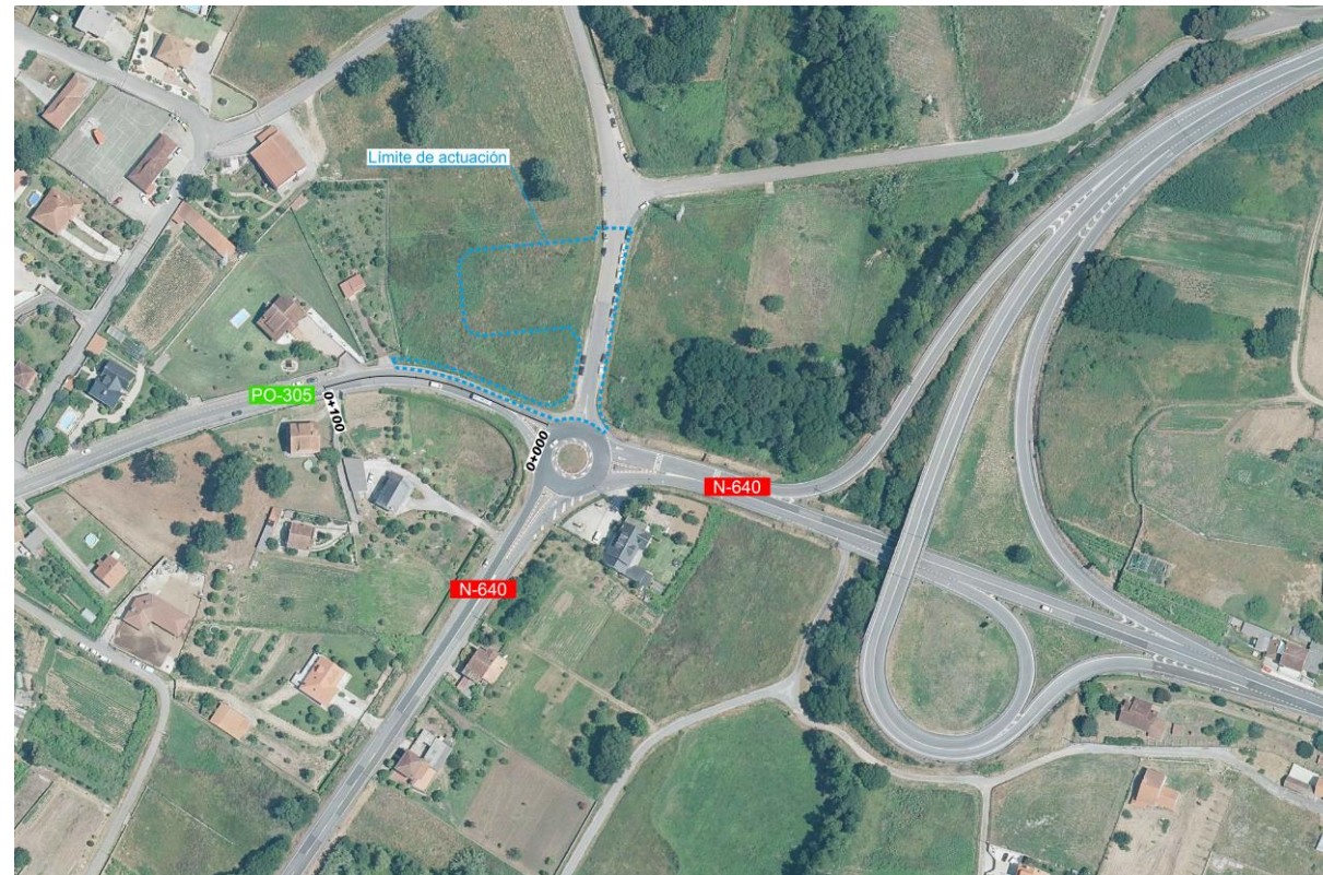
Figura 5. Ubicación del aparcamiento disuasorio en Caldas de Reis
