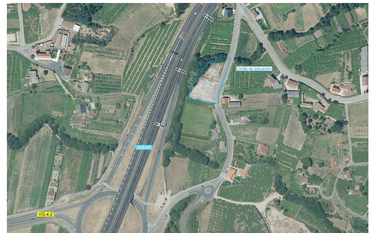
Figura 3. Localización do aparcadoiro disuasorio en Ribadumia
